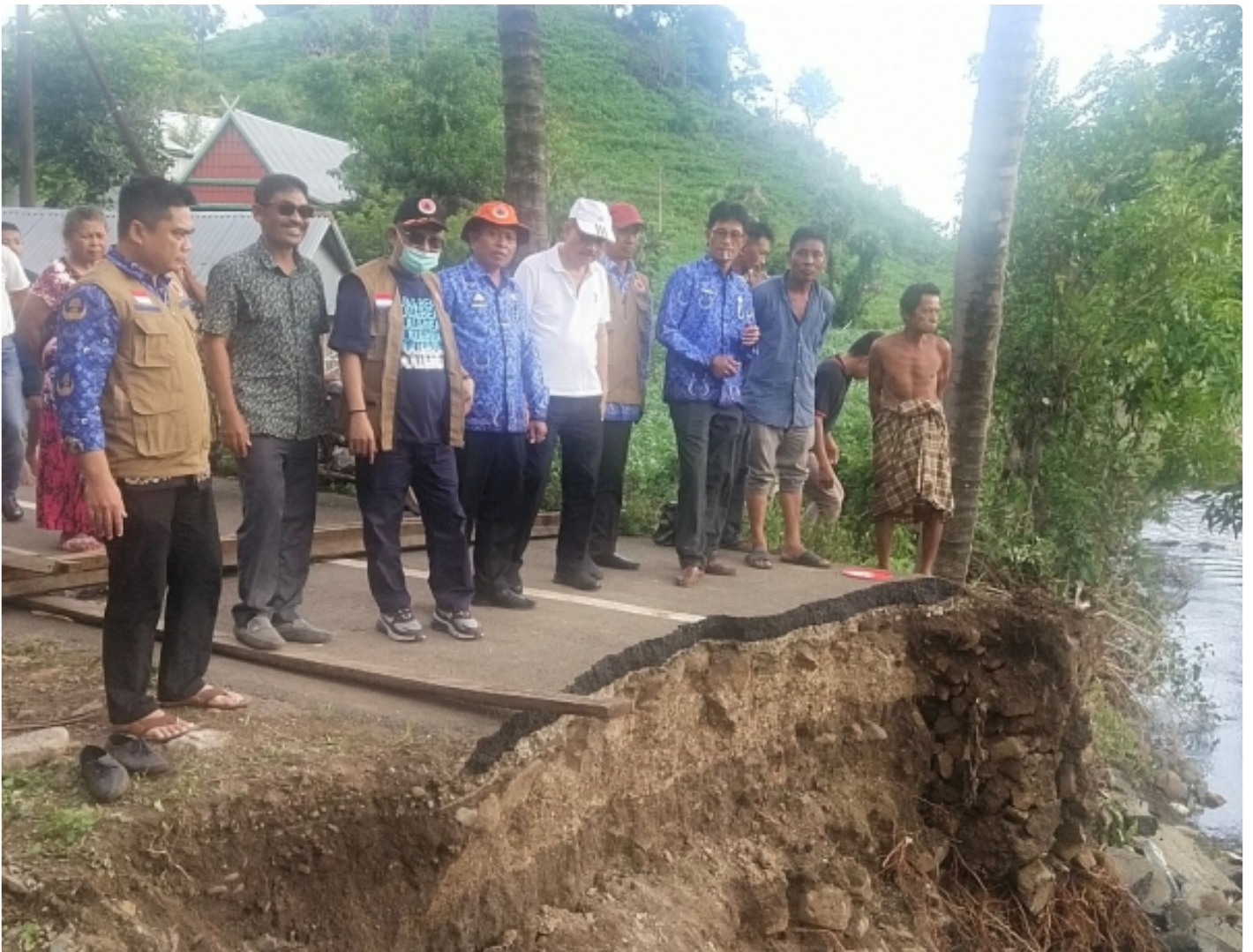
Plt. Kadis PUPR Muh Jafar Abbas dan Kadis BPBD Jeneponto, Ikrar Ishak Iskandar Pantau Kondisi Jembatan Runtuh di Desa Bulusuka
